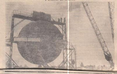
Огромный стальной шар диаметром в 10,5 метра монтируется на плодородной Магдебургской равнине, славящейся в ГДР высокими урожаями. Такие резервуары, предназначенные для хранения аммиачной воды, будут установлены в скором времени и в других местностях республики. Жидкие химические удобрения получают в сельском хозяйстве все более широкое применение.
