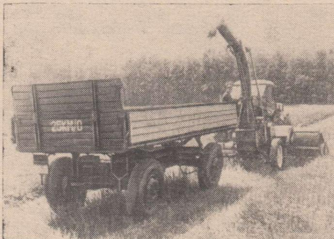
Новый образец сельскохозяйственной техники, выпущенный известным будапештским заводом «Красная звезда». К трактору «Дутра» присоединена сенокосилка. Свежескошенная трава поступает в кузов автоприцепа.
