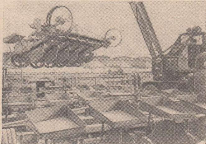
Серийный выпуск модернизированных шестирядных рассадопосадочных машин «СКН-6» начался на заводе «Моссельмаш».
